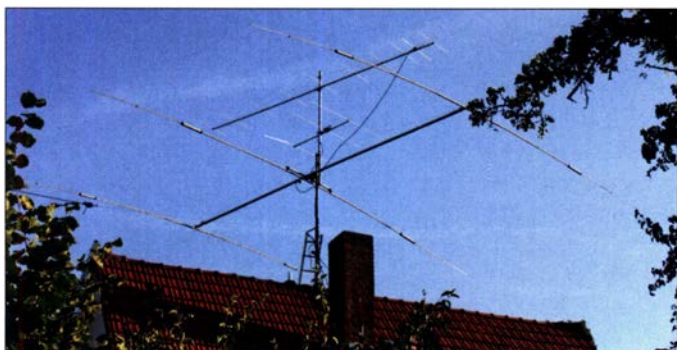
Bild 1: Dreiband-Beam UFB 33 auf dem Hausdach
