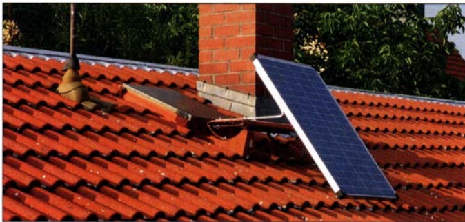
Bild 1: Provisorische Befestigung des Solarpanels an der Trittstufe auf einem Ziegeldach; die endgültige Montage muss so erfolgen, dass der Zugang zum Schornstein weiterhin uneingeschränkt möglich ist. Foto: DH0HUP
